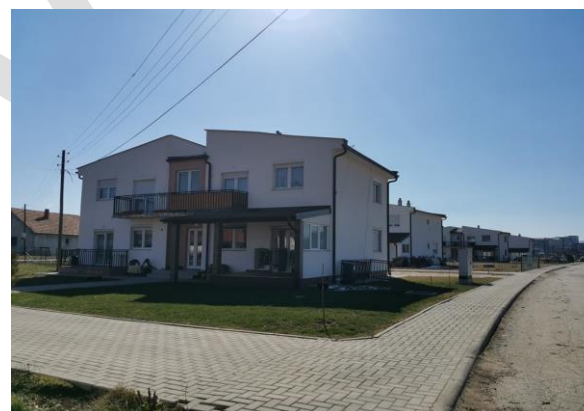
Slika 6. Stambene zgrade u Lapljem Selu
