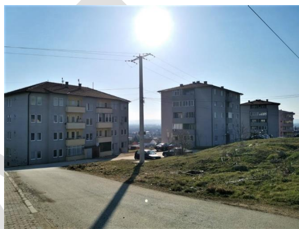
Slika 4. Stambene zgrade u Gračanici na Padalištu
